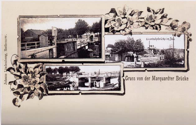
Portalzugbrücke mit massiven Stirnmauern von 1875 (links) Eisenbahnbrücke im Bau ab 1897, Eröffnung 1901 (rechts) Ansichtskarte aus dem Jahr 1900
